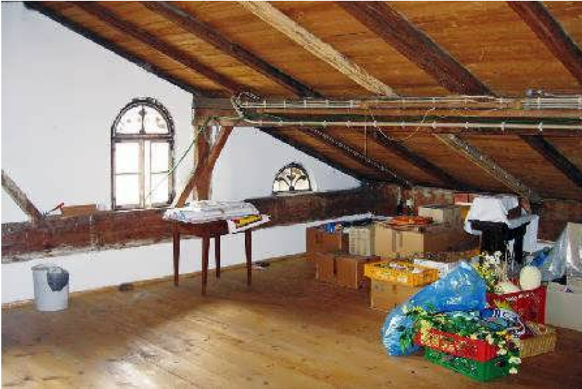
Chiemgau 33, Dachboden mit Zugang zum Bal
