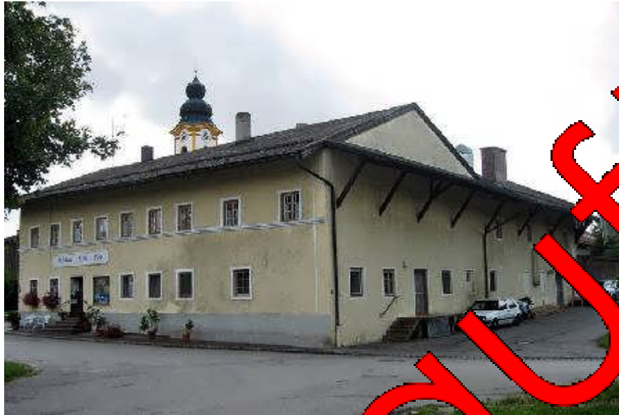
Chiemgau 33, Haupt- und Nebengebäude
