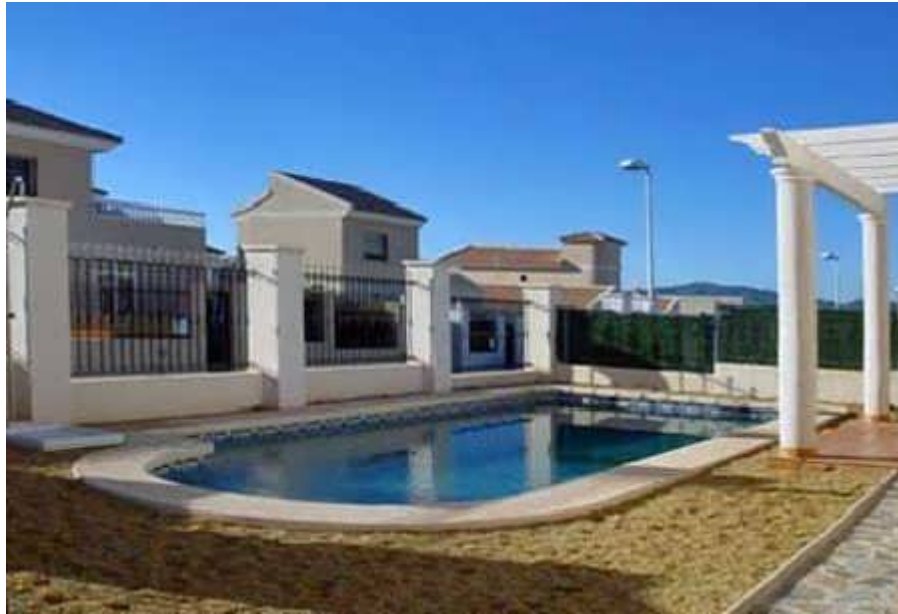
Swimmingpool mit Terrasse
